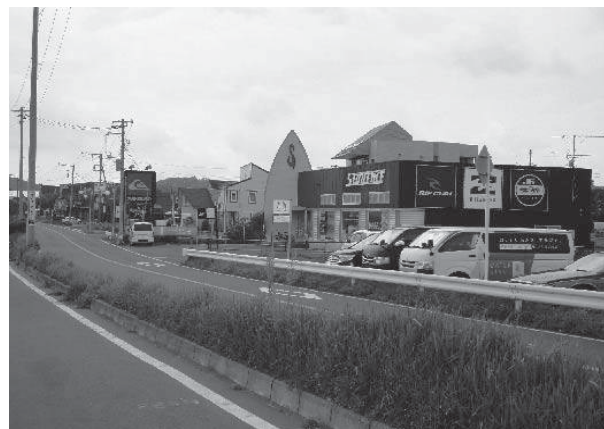
県道飯岡一宮線（通称：九十九里ビーチライン）沿いの状況
