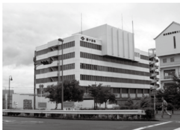
免震工事中の鎌ヶ谷市庁舎
