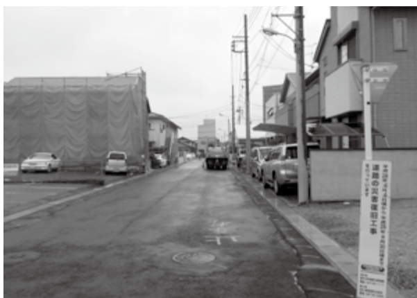
弁天1丁目道路舗装工事の様子
