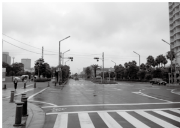
液状化対策により再生されたシンボルロード
