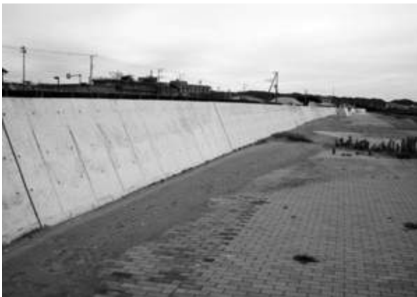
かさ上げされた飯岡海岸の防潮堤
