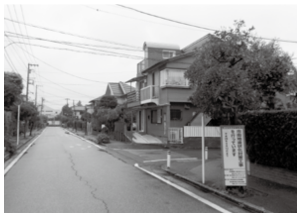
弁天2丁目市街地液状化対策事業予定地
