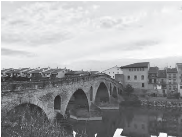
橋を渡り村を出る（スペイン）
