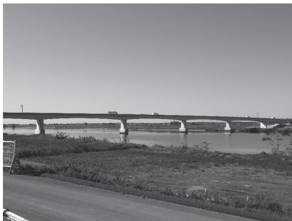
圏央道：県境の新利根川橋（神崎町地先）
