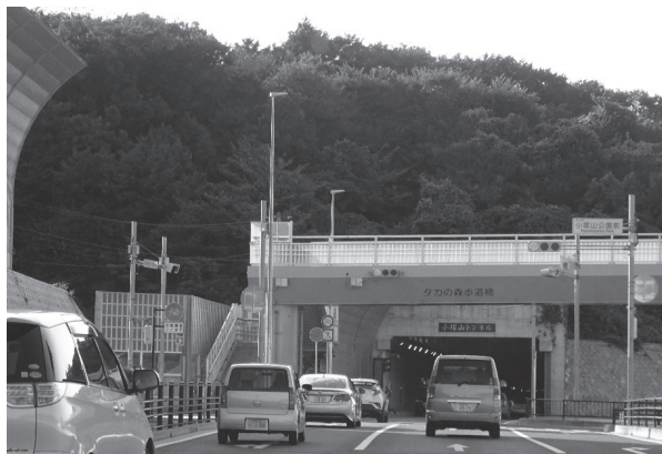
外環道（一般部）：国道298号 小塚山トンネル
