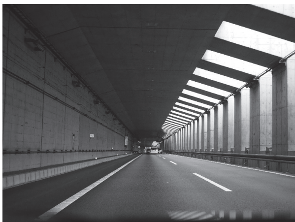
外環道（高速部）掘割構造部
