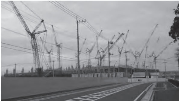
林立するクレーン（流山市 物流施設地区）
