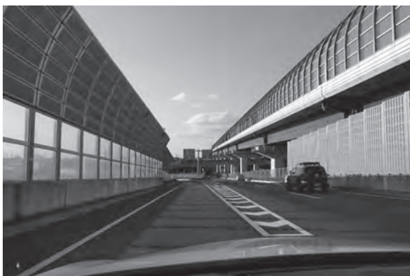
国道6号付近の外環道高架橋（右側）
